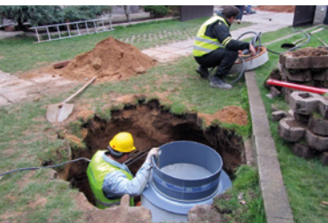
Křenek, kanalizace a ČOV
